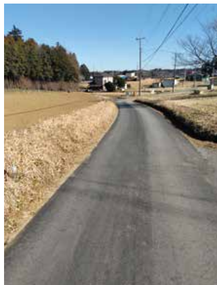
前原東山団地 道路舗装
