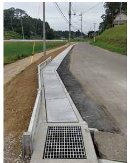
飯前地区 排水路整備
