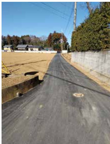
飯前地区 道路舗装
