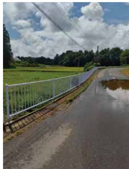
茂内池付近のガードフェンス整備
